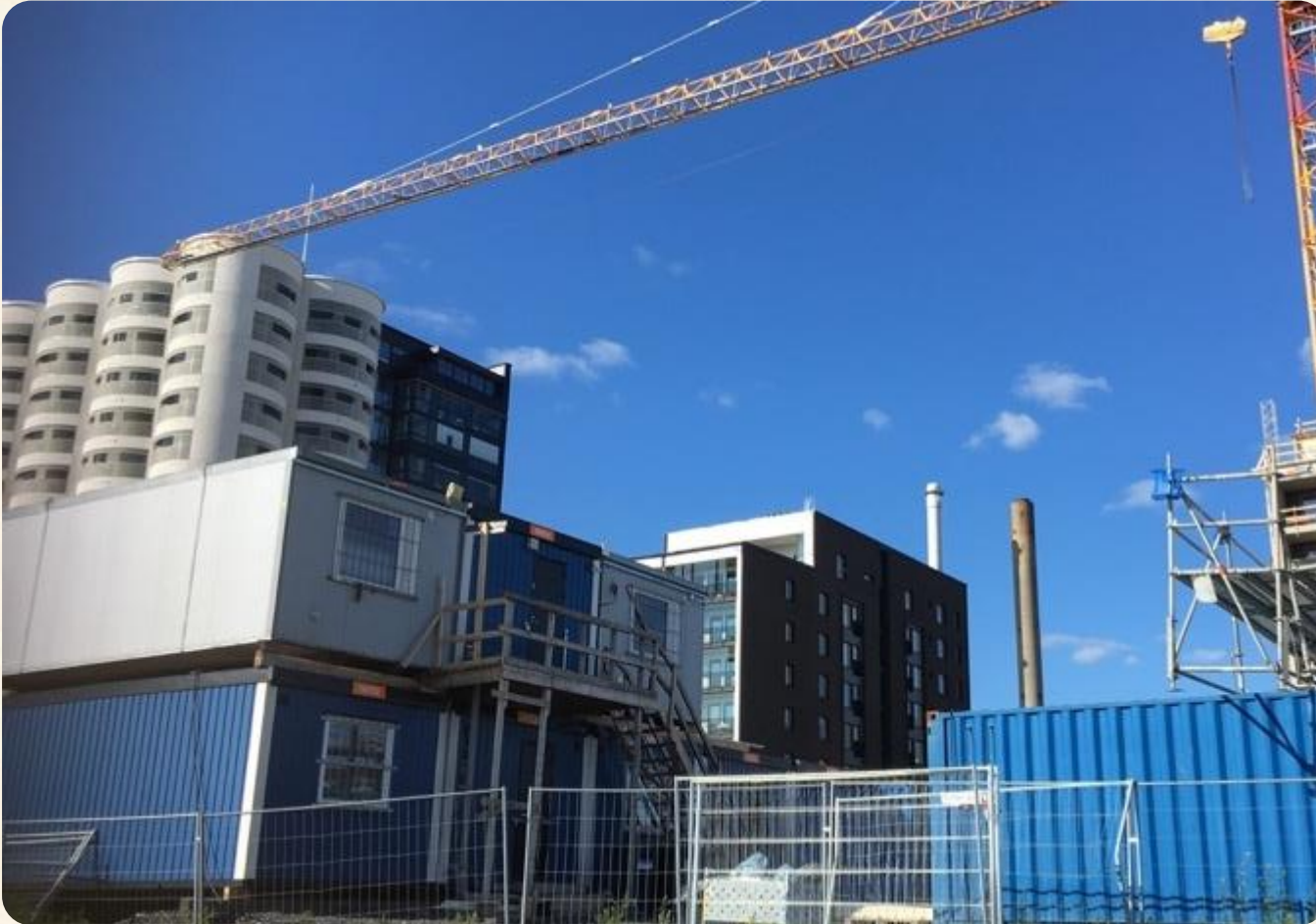
Uudistalon rakentamista Toppilassa.
