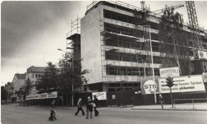
15.9.1977. Rakennustoimintaa. Kuva: Kalevan arkisto
